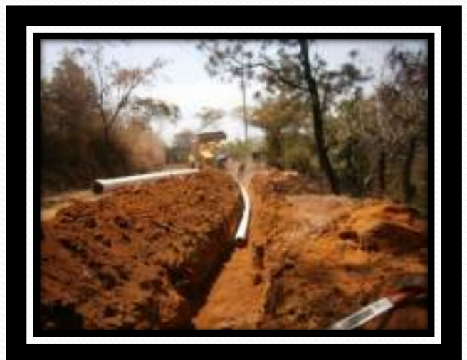
COLOCACION DE TUBERIA
