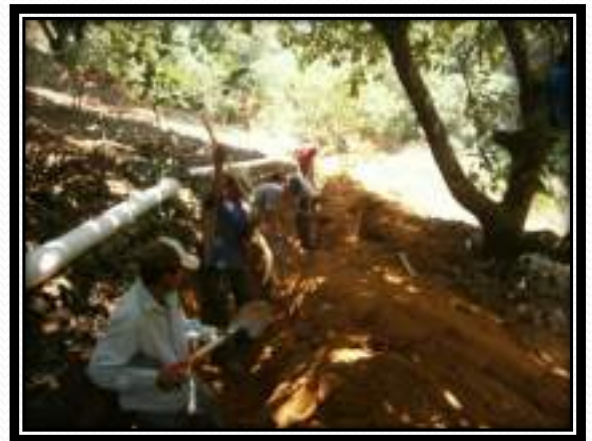
EXCAVACION A PICO Y PALA
