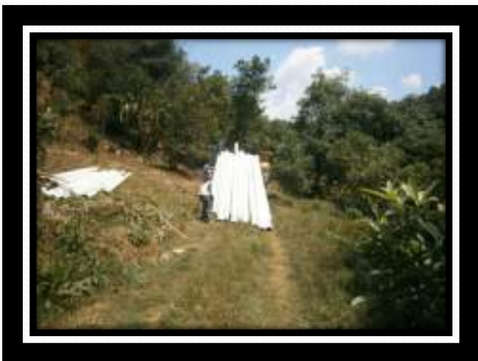
SUMINISTRO DE TUBERIA RD 26 DE 6”
